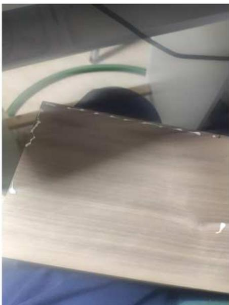
*Bild: 1.2 Hier nur die Ränder der Holzplatte mit Holzleim versehen, damit der innerer Bereich (Größe der Vorlage) frei von Holzleim bleibt*
