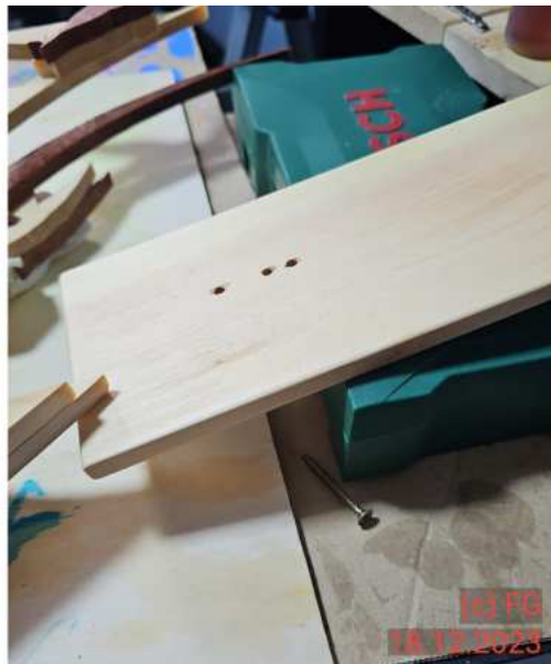
Bild: 2.8 Hilfsbodenbodenplatte anbringen
