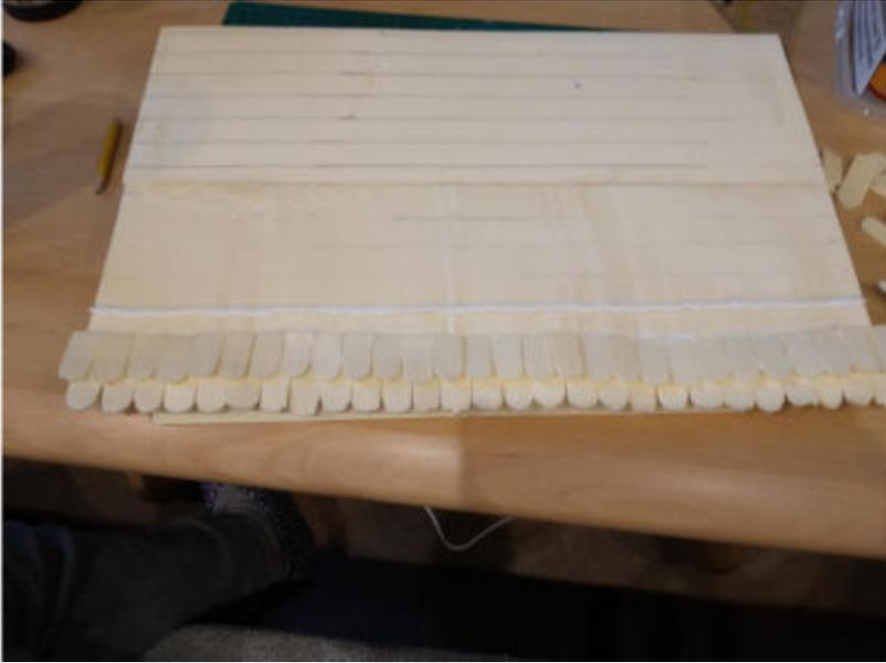
*Bild: 4.7 Abstände einzeichnen und von unten nach oben zum First arbeiten*
